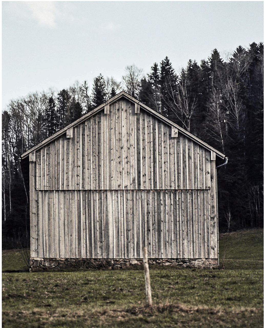
Bild 4: Fassade mit Deckelschalung
