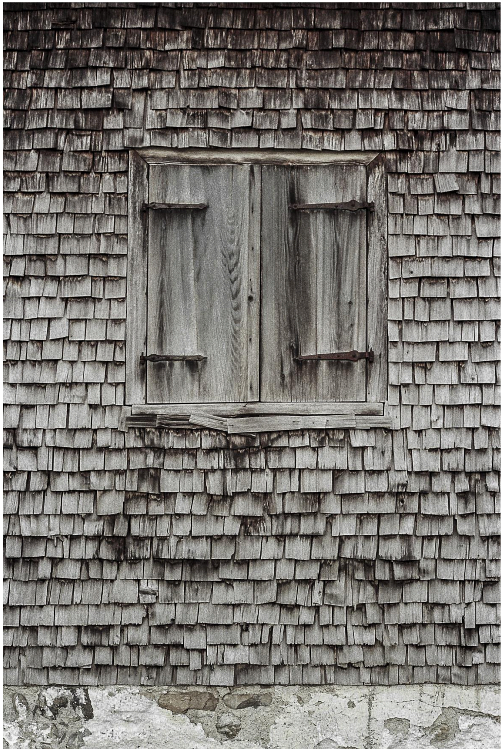
Bild 7: Fassade Bauernhaus mit Schindeln und quadratischem Fenster
